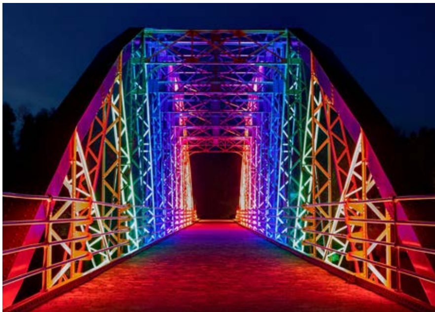
Puente de los Remedios, Villafranca de Cordoba 2022
